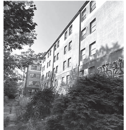
Obecny widok budynku dawnego internatu.
